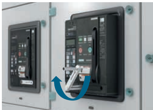
柜门关闭时，断路器可可靠的移动
