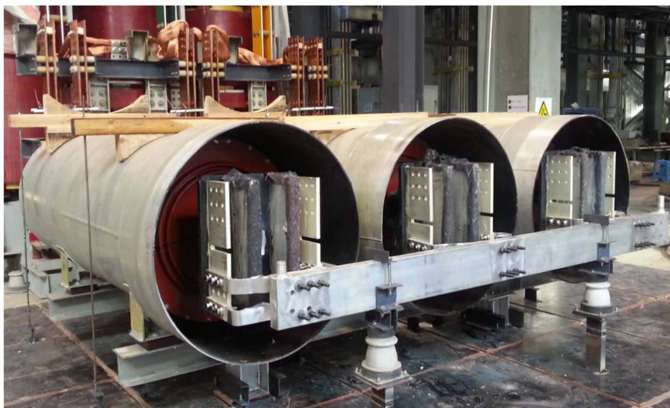
水冷离相母线整体布置图
